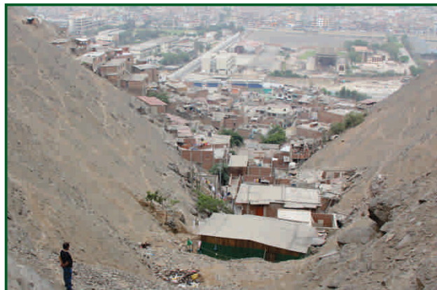
Viviendas asentadas en pleno cauce de una quebrada, que se encuentran expuestas a flujos de agua y escombros
