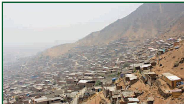
Vista panorámica donde se aprecia el terreno del distrito de Independencia con diferentes pendientes.
